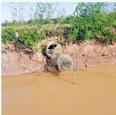
Hình 2: Cống cấp và thoát nước
